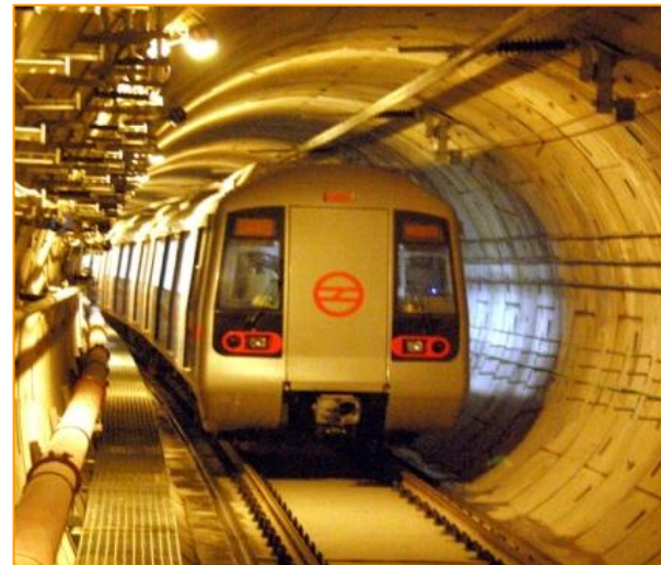
インド 「デリー高速輸送システム建設事業」
