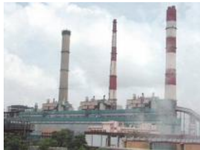
インド 「バクレスワール火力発電所建設事業」
