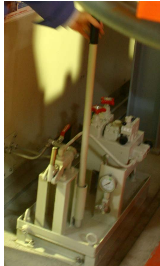
ゲートの手動操作作用レバー
