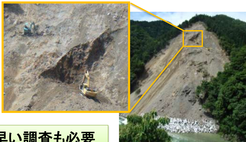
無人化施工による災害応急復旧状況
