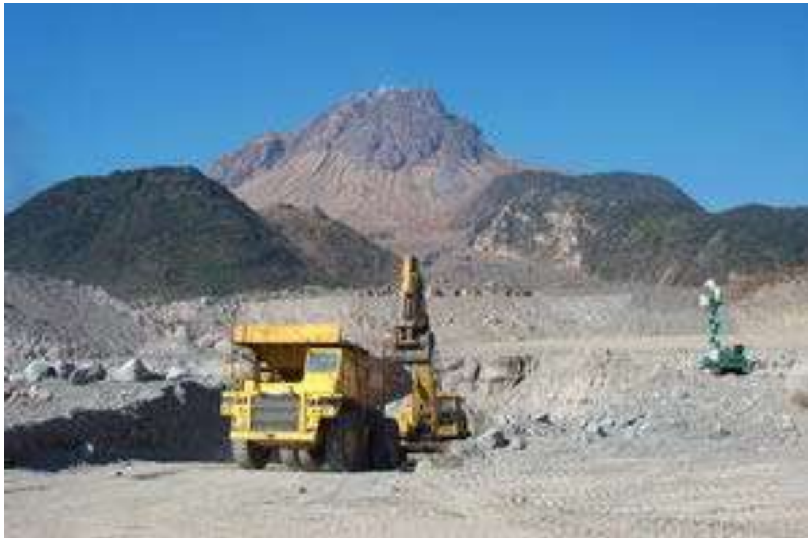
無人化施工技術による砂防ダムの建設
