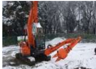
建設系現場のロボット
