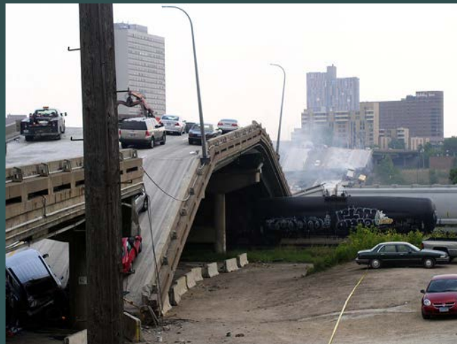
米国ミネアポリスI-35W落橋事故 https://commons.wikimedia.org/wiki/File:I-35W_bridge_collapse_TLR1.jpg
