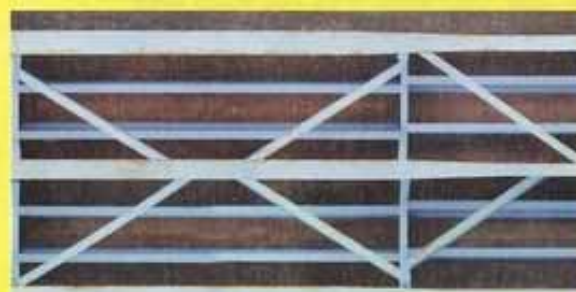
橋梁の下を無人ヘリが遠征撮影し、合成した写真。橋は長さ約80m、幅員約10mの単純鋼桁橋である。ルーチェサーチでは、コンピュータ工学を専門とする広島工業大学の十河茂幸教授の助言を受けて、構造物の点検に取り組んでいる(写真:左はルーチェサーチ)
