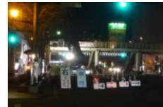
工事現場の写真
