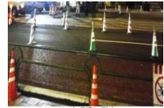
工事現場の写真
