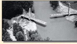
中規模橋梁: 2主桁、回転工法
