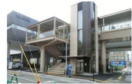
2) 駅舎側階段とエレベータ
