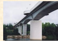
複合橋梁(波形鋼板)
