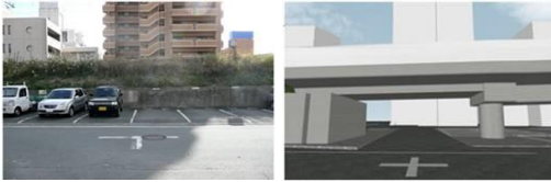
施工前(土手撤去前)
