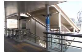
4) 階段降り口(柱状サイン設置)
