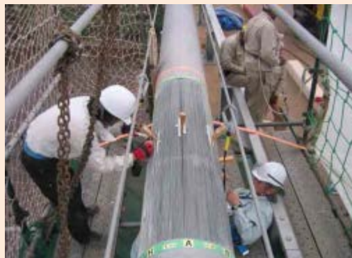
マタディ橋の開放調査の状況
