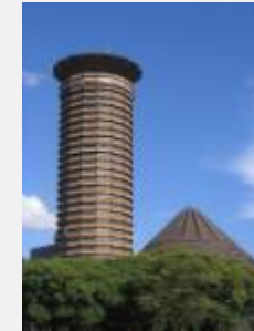
KICC(ケニヤッタ国際会議場)
