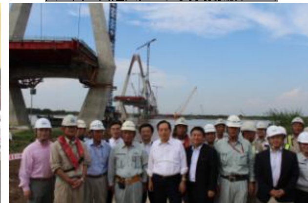
太田国土交通大臣による現場激励(H25.9)
