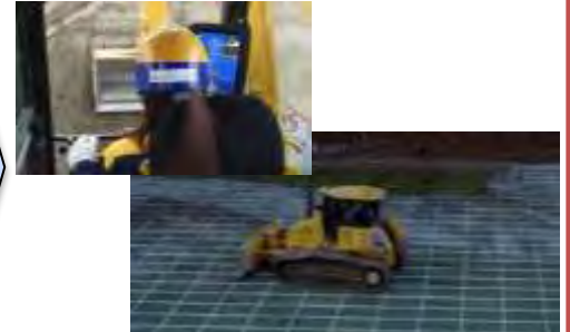
ICT建機による施工
