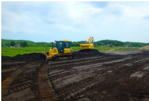
ICTブルドーザによる敷均(6月7日撮影)
