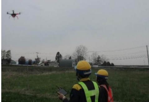
UAV(ドローン)による施工前の測量(5月10日撮影)
