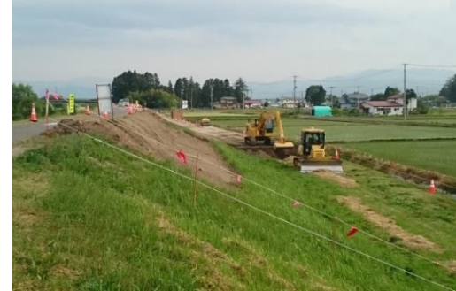
ICTバックホウによる表土剥ぎ取り(6月8日撮影)
