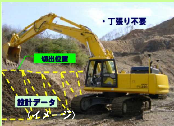
▲マシンコントロールバックホウ技術
