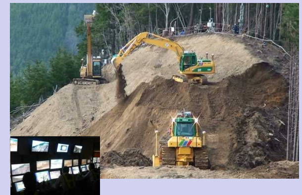
▲災害応急復旧ロボット(無人化施工)
