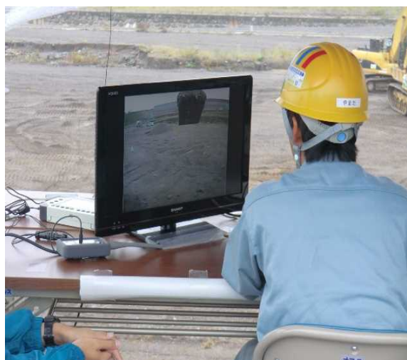
目視掘削実施状況
