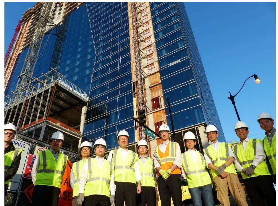
McCormick Place Hotel建設現場にて
