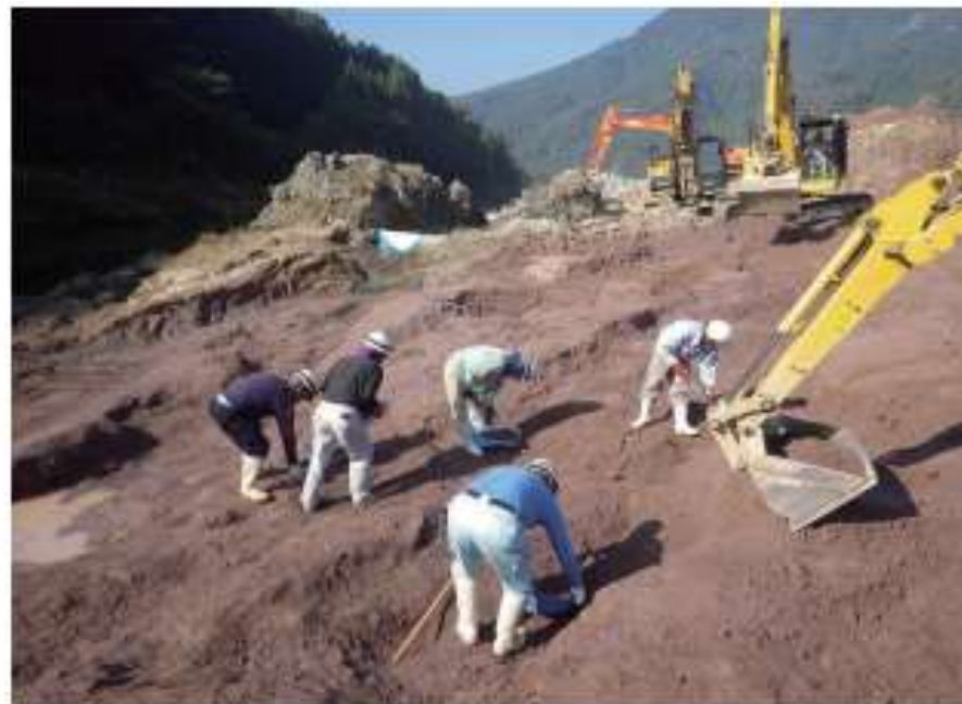
写真 5-1-21 人力による仕上げ掘削
