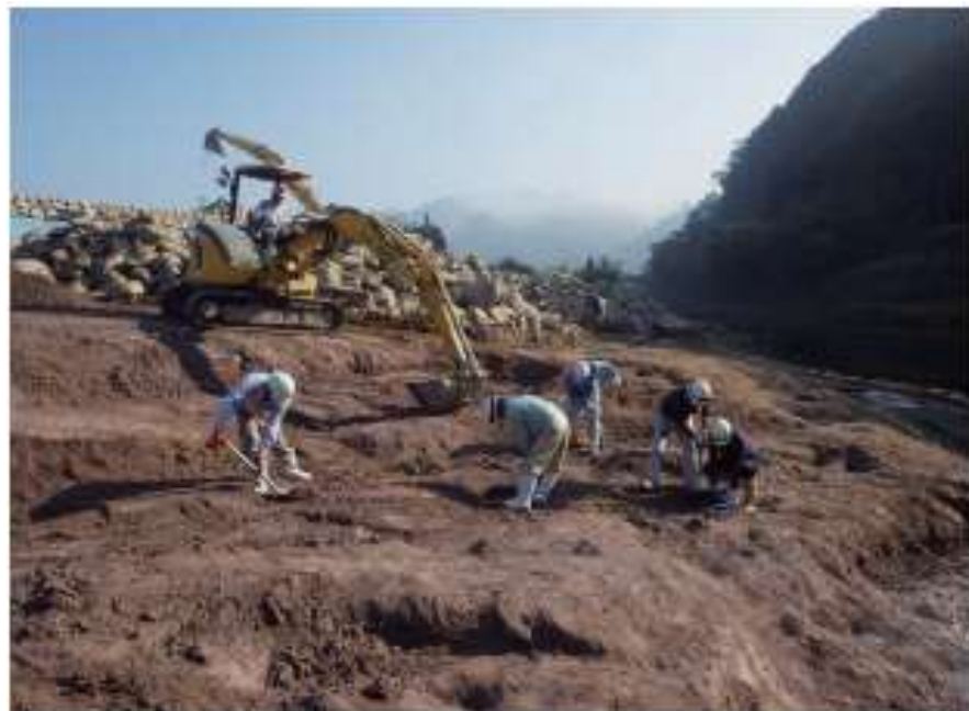
写真 5-1-20 人力による仕上げ掘削
