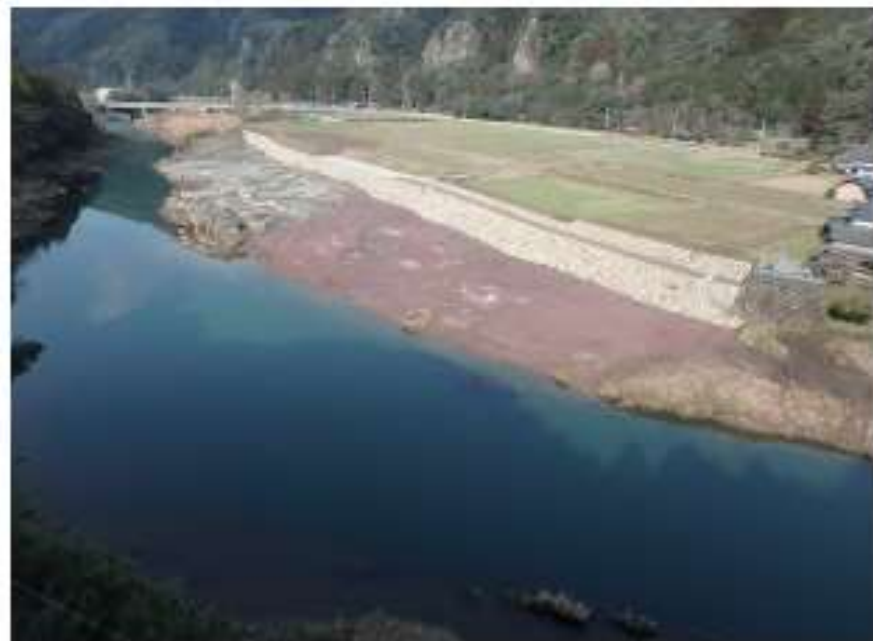
写真 5-1-4 上曾木地区 完成
